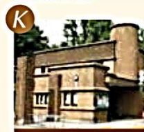
K 広報センター Information Center 学内外を問わず利用できる大学広報施設として平成7(1995)年に開設。建物は大正15(1926)年1月竣工。 ※東京都選定歴史的建造物
