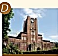
D 安田講堂 Yasuda Auditorium 安田善次郎氏の寄附により大正14(1925)年に竣工。高さ39.7m。現在は式典・公開講座・五月祭などで使用されている。※登録有形文化財
